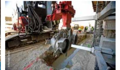
Les deux tambours rotatifs de l'outil dérivé de l'hydrofraise effectuent le forage et le malaxage du sol avec le liant.
