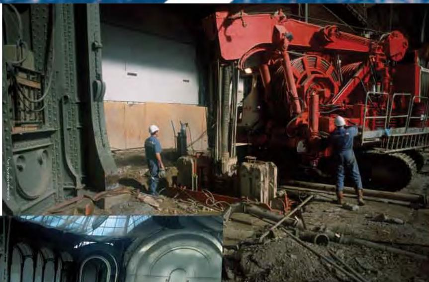
Une hydroraise de petit gabarit a réalisé la paroi moulée.
