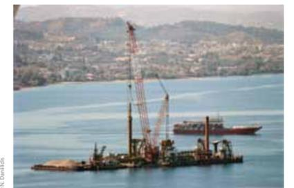
La barge à pieds tendus en train d'enfoncer les tubes dans le fond de mer grâce à un marteau de 70 tonnes.
