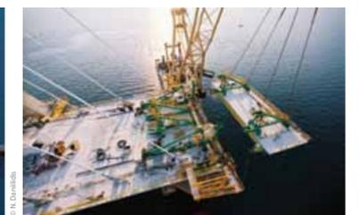
Élévation du pylône de la pile. Les haubans soutiennent le tablier du pont.
